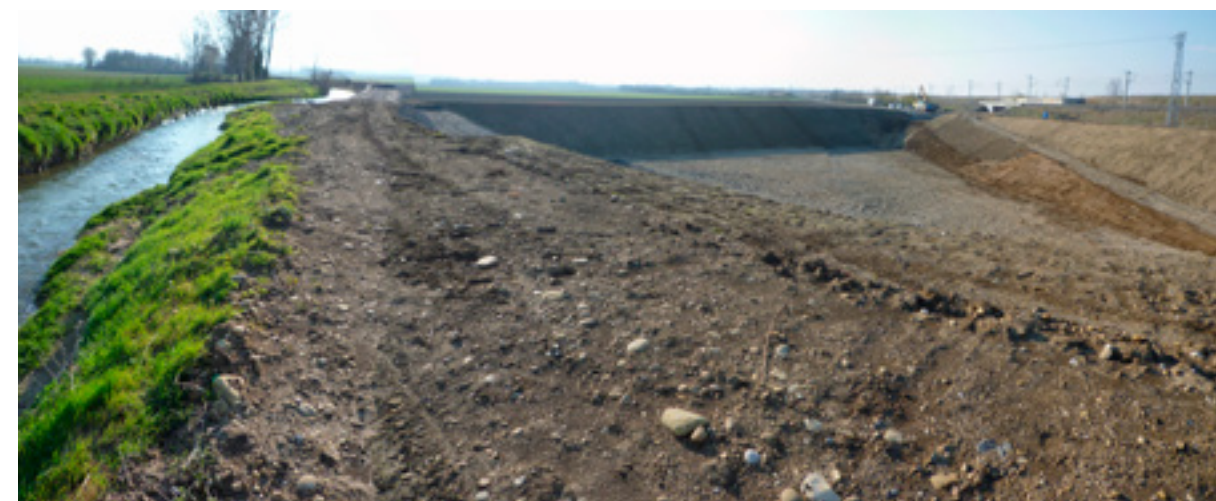
Les bassins de rétention et d'infiltration de Fauconnières sur le Guimand (26)
