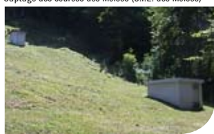
Captage des sources des Moises (S.I.E. des Moises)
