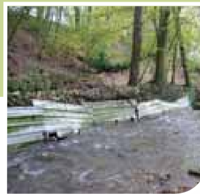
Des protections de berges inefficaces et inesthétiques. Le Redon à Sêchex
