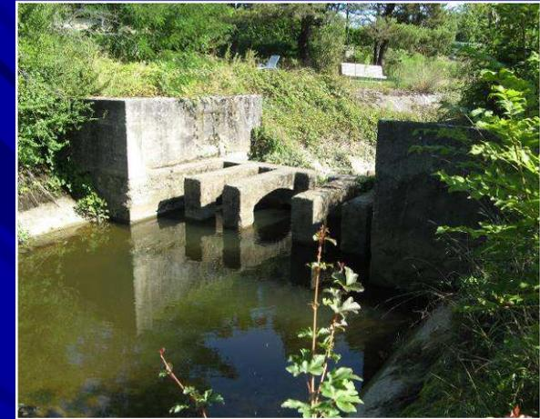
**Avant travaux** : secteur canalisé, section d'écoulement insuffisante, aucun habitat, végétation quasi inexistante ...
