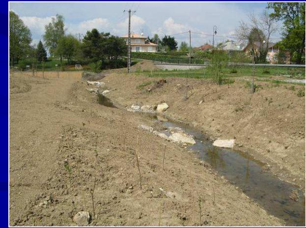
**Pendant travaux** : emprises foncières plus importantes, suppression des ouvrages béton, création de sinuosités, berges en pente douce, élargissement de la section d'écoulement ...
