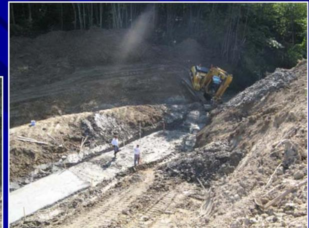
Mise en place du béton de propreté
