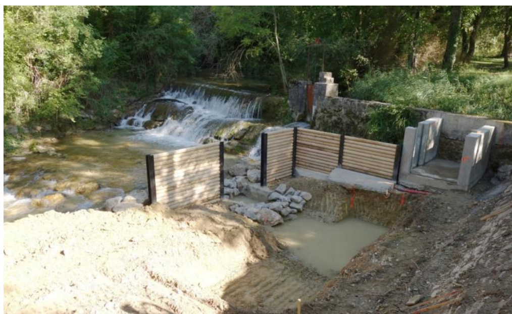
Phase travaux : création d'une rivière de contournement en rive gauche
