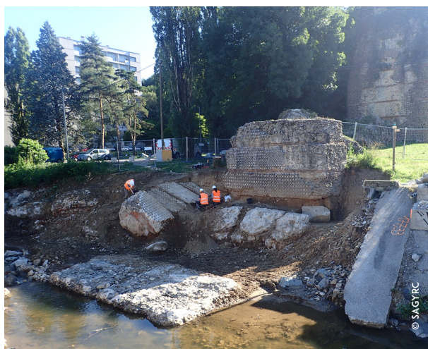
Fouilles préventives au pied de l'aqueduc
