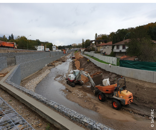
Matelas en gabions en pieds de berge
