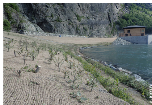
Lits de plants et plançons en bord de berge et boutures et plants (après chantier)
