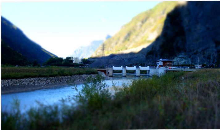
Barrage-prise d'eau ouvert
