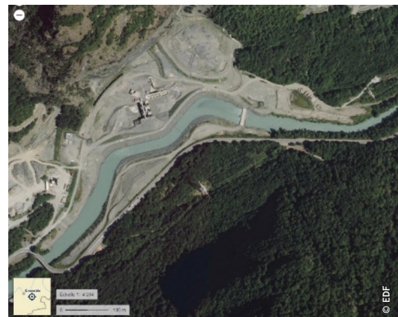
Emprise du chantier
