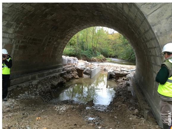
Radier sous l'arche centrale, prise de vue côté amont : avant et après destruction
