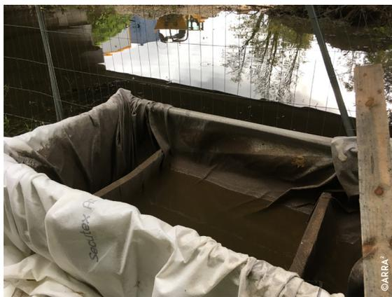
Cage recouverte d'un géotextile permettant de filtrer les eaux de bétons
