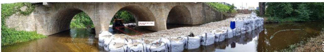
Mise hors d'eau à l'amont et accès des engins à la voute centrale
