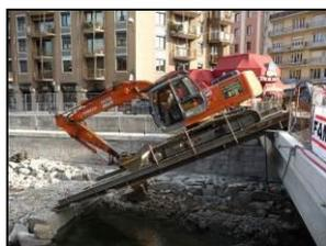
En rive droite, un terrassement a été réalisé pour créer des banquettes et permettre un reméandrage du cours d'eau, dans la mesure du possible étant donnée la canalisation entre deux murs. Les fondations des murs de quais ont été mises à jour et les vides ont été comblés au ciment. Le pied du mur a été conforté et des enrochements percolés au ciment ont été posés pour conforter les quais.
