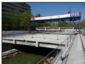
Voici une photo de la Leysse découverte avant travaux. On aperçoit un massif en béton en rive gauche qui correspond à l'exutoire du réseau d'eaux pluviales impossible à supprimer ou à déplacer. Il a donc fallu prendre en compte ce critère dans le projet de renaturation.
