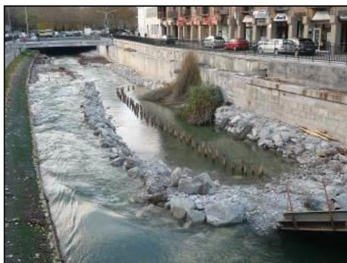
Une troisième banquette a été mise en place derrière le batardeau. La brigade bleue a participé au fascinage. La coco a ensuite été installée puis la banquette a été rechargée en matériaux (mélange pierre/terre). Du géotextile a été installé avec un renfort en treillis soudé et des fagots de boutures ont été mis en place.
