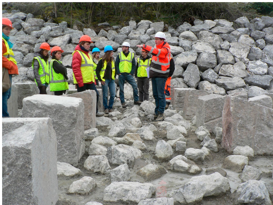
Visite du chantier de Marignier par Emmanuel RENO, chargé de mission au SM3A
