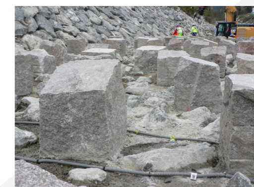
Mise en place du système de radiopistage
