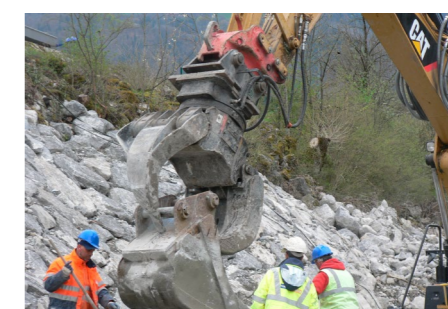
Pose des blocs
