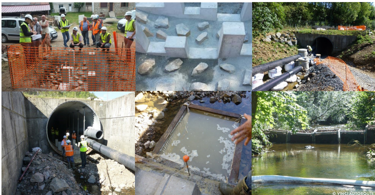
images de la phase chantier
