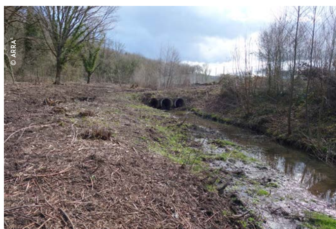
Suppression du passage busé à proximité du site Renaud Trucks
