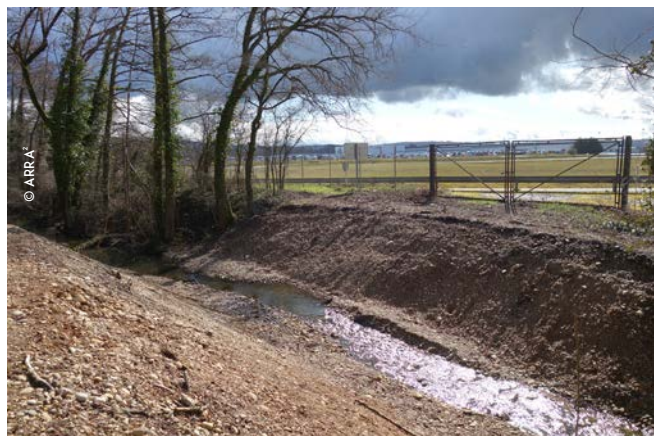
Suppression du passage busé à proximité du site Renaud Trucks
