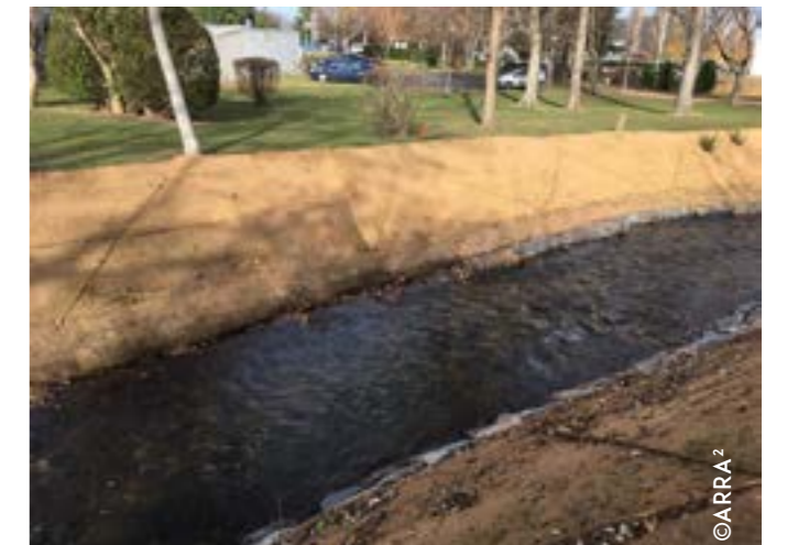
Affaissement des gabions en pied de berge
