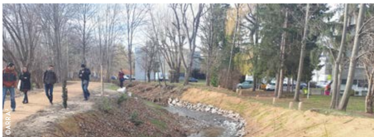
Aménagement d'un gradin, d'une zone de repos et d'un accès à la rivière
