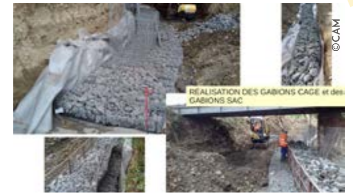
Phase travaux : réalisation des gabions cages et gabions sacs
