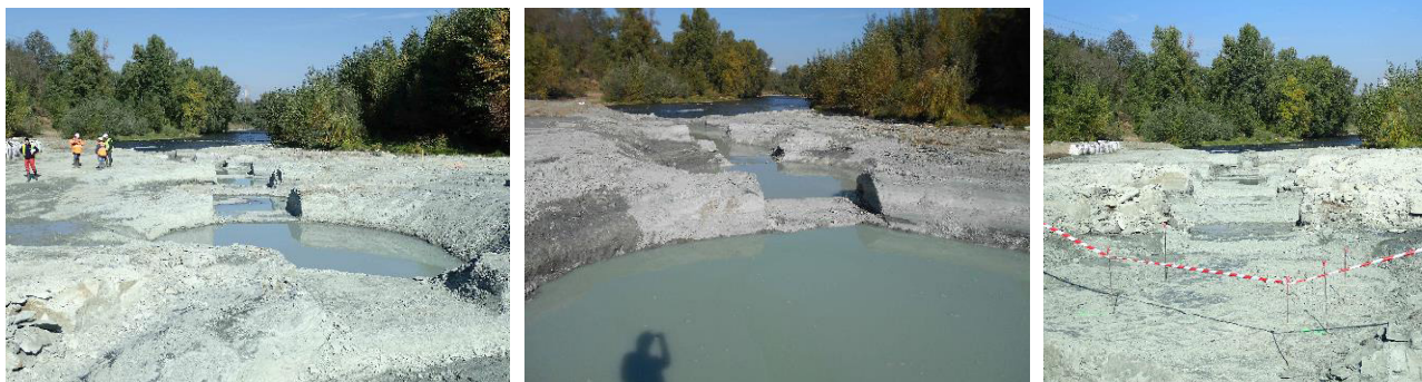
Bras gauche terrassé - Vue de l'amont (l'Allier au fond)
