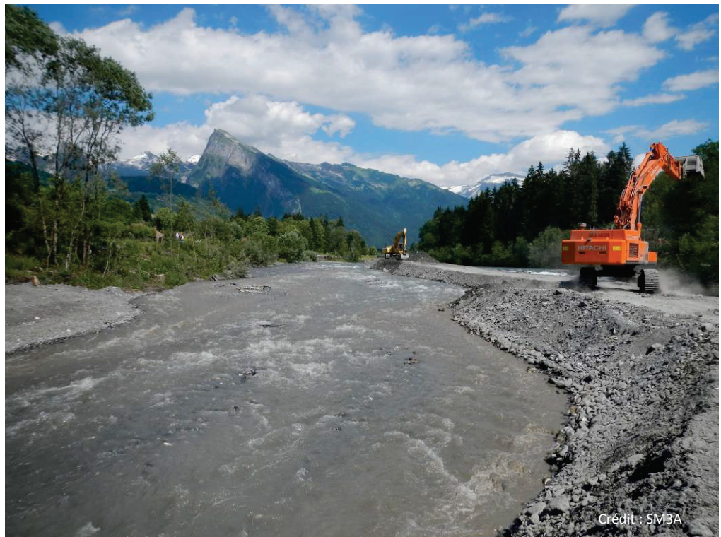
20 juin 2014 : Création d'un batardeau central de l'amont du nouveau lit jusqu'à la crête du seuil (vue vers l'amont depuis le nouveau bras, la seconde pelle se trouve au niveau du seuil)
