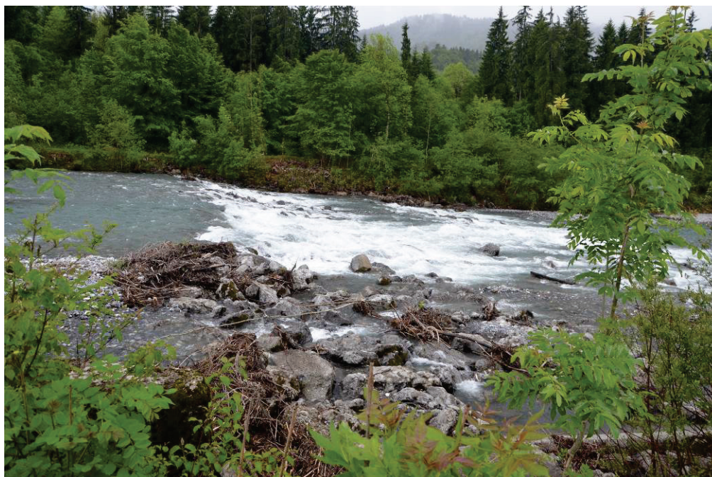
Seuil de stabilisation avant intervention : les deux blocs esseulés en bordure du remous sont issus de la crête du seuil. Ils étaient encore en place l'été dernier.
