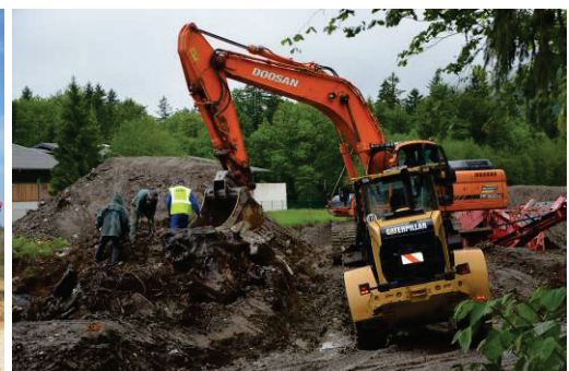
Le tri des matériaux est effectué à l'aide d'un scalpeur (à gauche ; Crédit : SOVAMAT) puis d'une finition manuelle (à droite).
