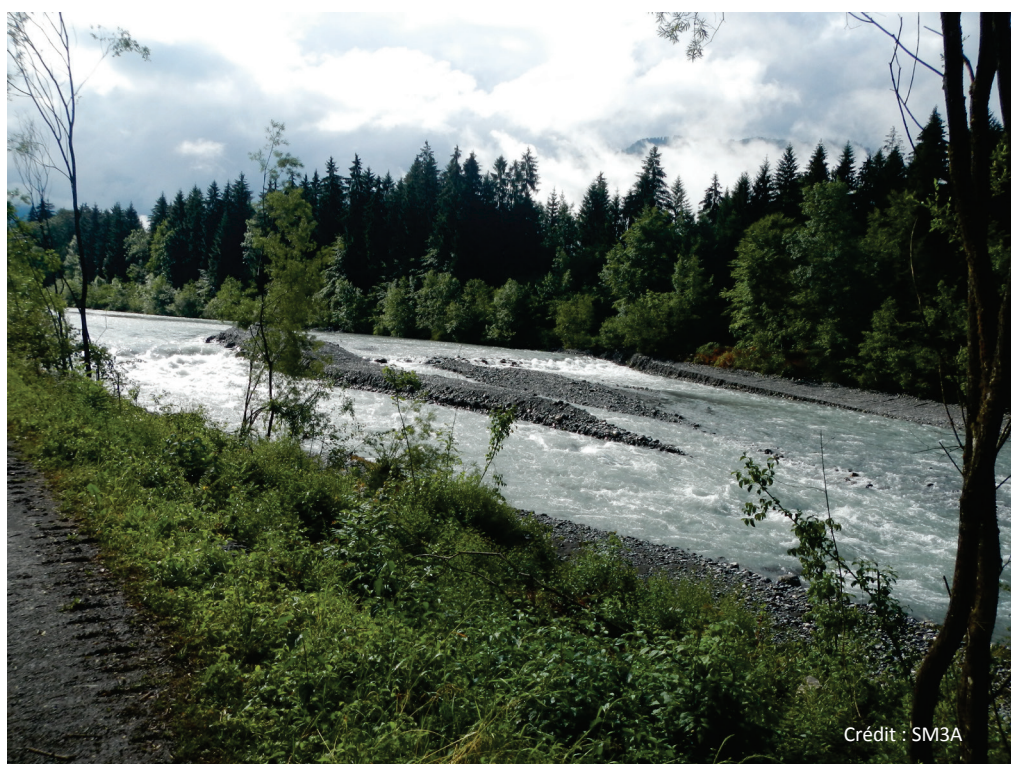
30 juin 2014 : vue du seuil après travaux. Les travaux sont terminés depuis peu et une 1 ère crue a déjà remodelé le cours d'eau. L'aval direct du seuil a été rehaussé par la réinjection des matériaux.
