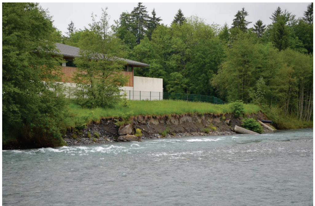
Station de traitement des eaux de Morillon (74) menacée par l'érosion des berges du Giffre (mai 2014)
