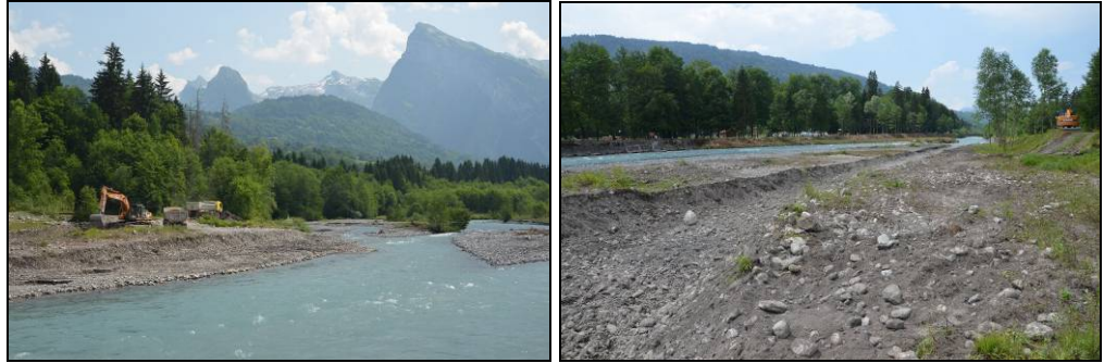
Extraction de matériaux et ouverture d'un bras secondaire sur le banc de rive droite en amont du pont de Verchaix à Morillon
