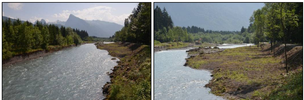
Abattage des arbres sur le banc de rive gauche en amont du pont de Verchaix à Morillon
