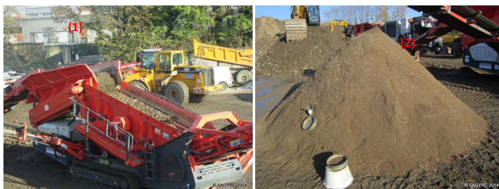
Vue de détail du second cribleur (grille utilisée : 0-10 mm) (1) / Partie fine contenant les rhizomes de renouée neutralisés (fraction < 10 mm) (2)
