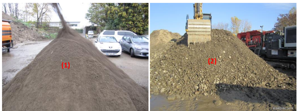
Vue de détail des matériaux produits après criblage. La partie fine (1) est évacuée en décharge de classe 3 alors que la partie grossière « contaminée » (2) est concassée.
