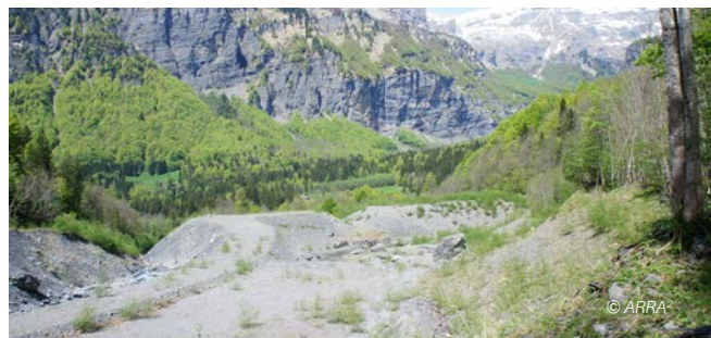
2016 - Merlon freineur amont, piège à matériaux
