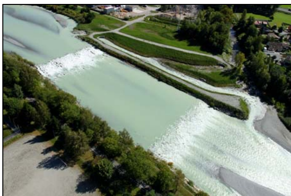
Le Foron de Scionzier en aval du seuil de stabilisation : utilisation de techniques végétales
