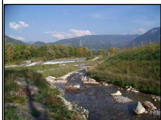
Le Foron de Scionzier en aval du seuil de stabilisation : utilisation de techniques végétales
