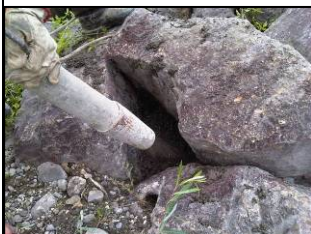
Remplissage par projection
