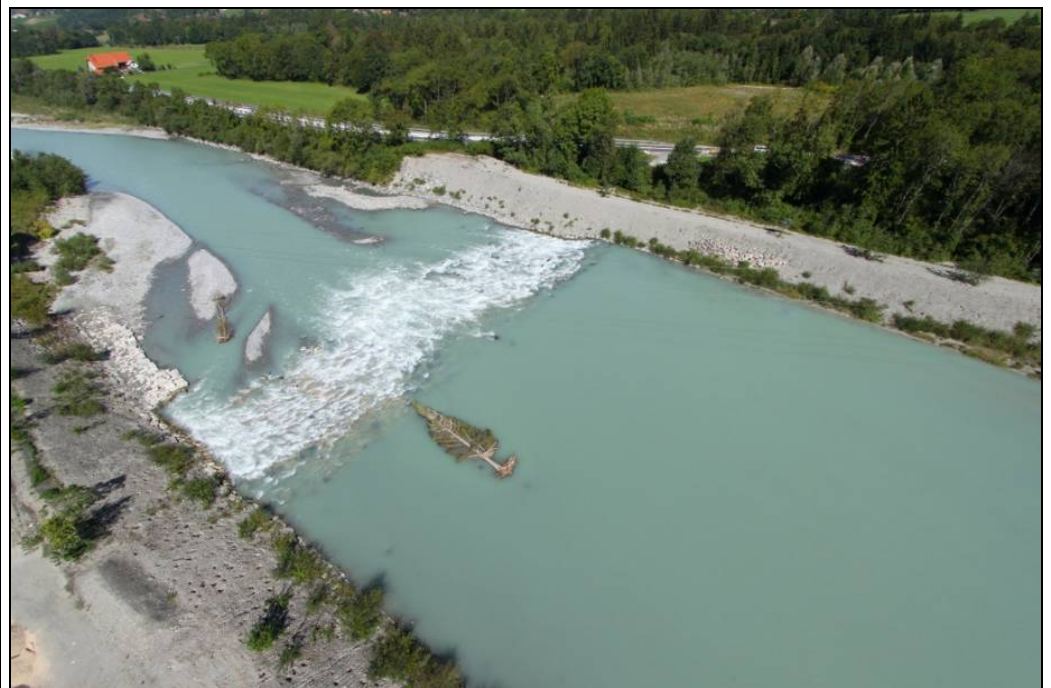
Situation après la 1 ère phase de travaux : remplissage des interstices et placage de terre (vue vers l'aval)
