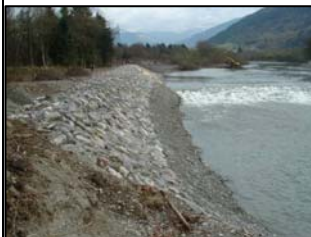
Situation avant travaux
