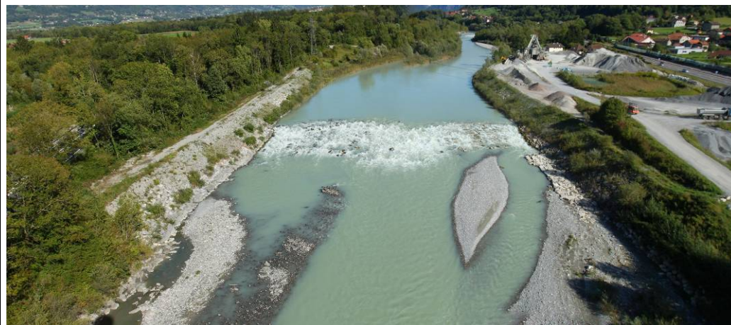
Situation après travaux : végétalisation des différentes placettes et reprise végétative (vue vers l'amont)
