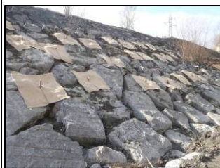
Mise en œuvre des pieux vivants et collerette de géotextile
