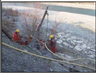
Forage et mise en œuvre des pieux vivants
