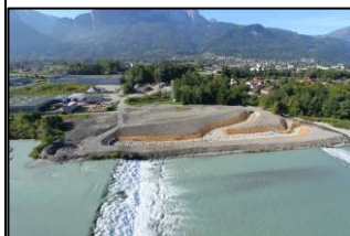
Situation après terrassement
