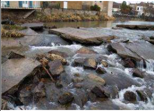
Etat initial du seuil
