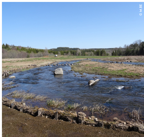
génie végétal en berge
