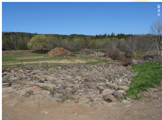
lit de dérivation aménagé en bras de décharge
