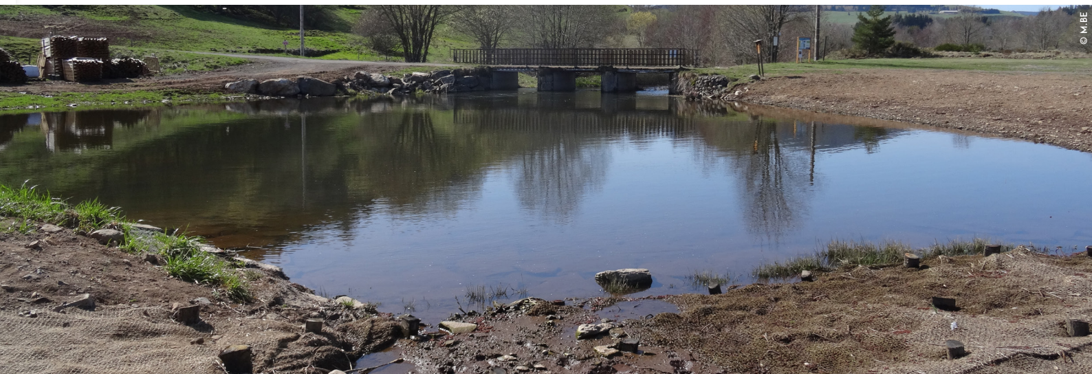
fosse de dissipation en amont du site
