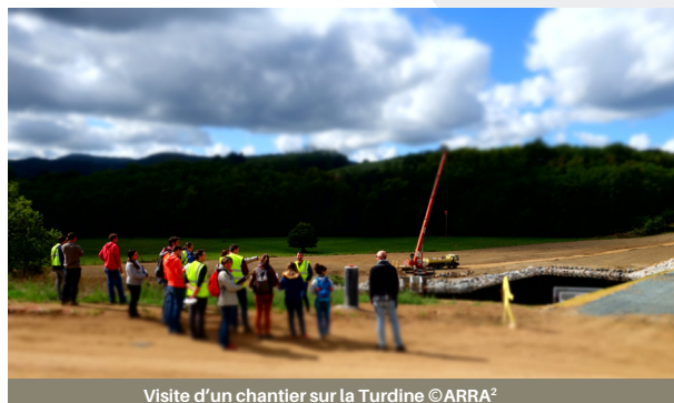
Visite d'un chantier sur la Turdine ©ARRA²
