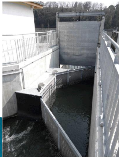
Défecteur amont avant et après travaux
