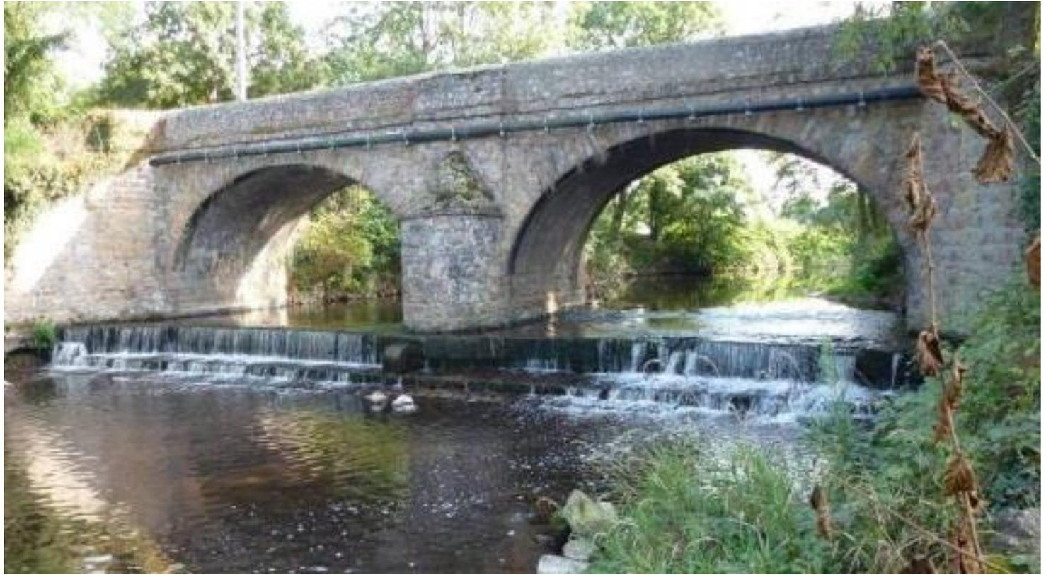
Seuil de stabilisation du pont : radier en pierres maçonnées
