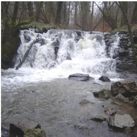
Seuil de Chazotier sur l'Yzeron 2,50m réaménagé avec rampe à 4%
