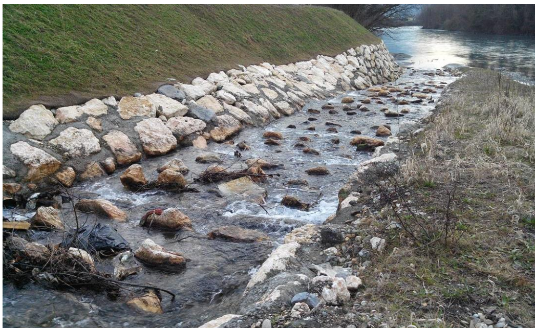
Confluence ruisseau de la Combe de Lancey 4,5 m aménagé avec rampe à 6-7%
