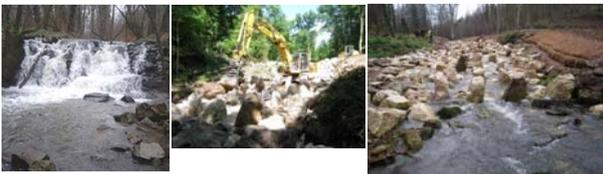
Seuil de Chazotier sur l'Yzeron 2,50m réaménagé avec rampe à 4%
