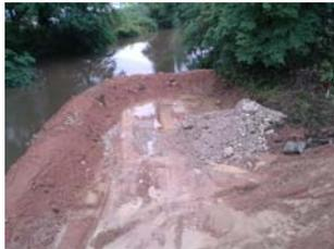
→ Batardeau en remblais efficace pour les faibles débits mais devient fragile dans le temps (érosion en pied, ...)
