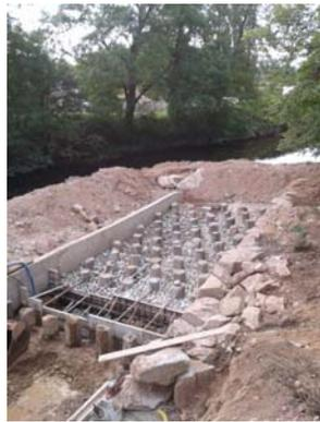
→ Mode opératoire nécessitant de poser les blocs de dissipation en même temps que les éléments de fonds
