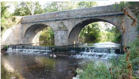
Seuil de stabilisation du pont : radier en pierres maçonnées
