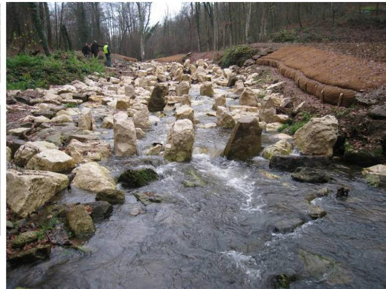
**Seuil de Chazotier sur l'Yzeron 2,50m réaménagé avec rampe à 4%**
