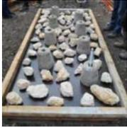
• Planche d'essai et réalisation macro rugosités
