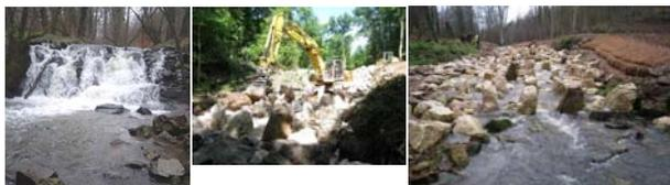
Seuil de Chazotier sur l'Yzeron 2,50m réaménagé avec rampe à 4%
