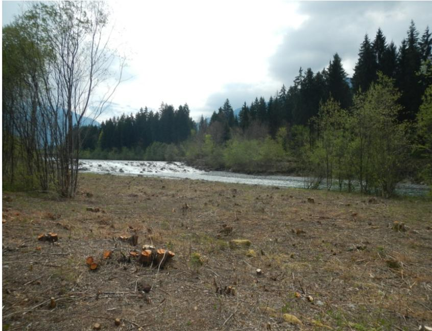
Ouverture d'un bras secondaire de 20 m de largeur sur 300 m de long et 2 m de hauteur
