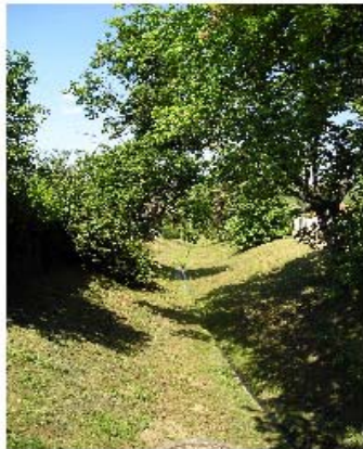
Noue, fil d'eau et micro-barrage pour gérer l'écoulement de l'eau
