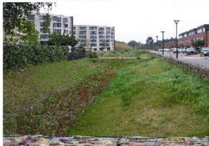
Noue, fil d'eau et micro-barrage pour gérer l'écoulement de l'eau
