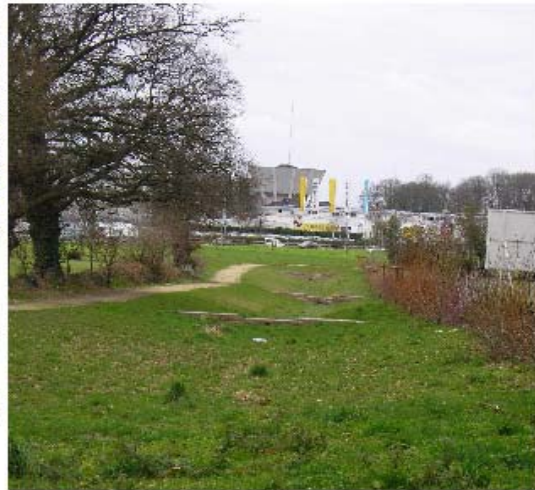
Noue, fil d'eau et micro-barrage pour gérer l'écoulement de l'eau
