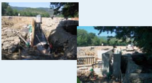
Coulage des parois verticales de la passe Pose des bassins transversaux
