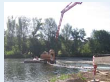
Mise en sécurité et fermeture de l'ancienne passe à poissons (au milieu du seuil, contigue à la passe à canoté)
