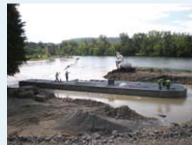
Pose des caillebotis de sécurité Mise en eau de l'ouvrage
