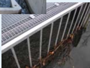
Embrasures à éliminer régulièrement (entrée amont de la passe)
