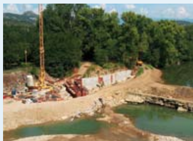
Coulage des parois verticales de la passe Pose des bassins transversaux
