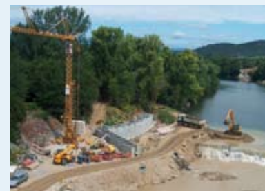
Pose des callebotis de sécurité Mise en eau de l'ouvrage
