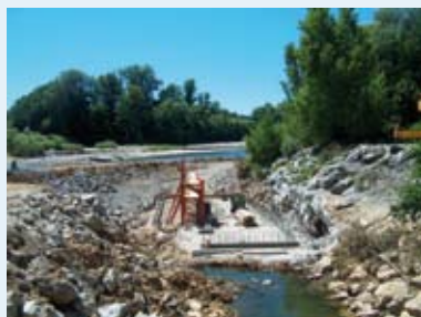
Mise hors d'eau de la zone de chantier Fondations de la passe
