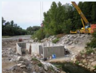
Coulage des parois verticales de la passe Pose des bassins transversaux
