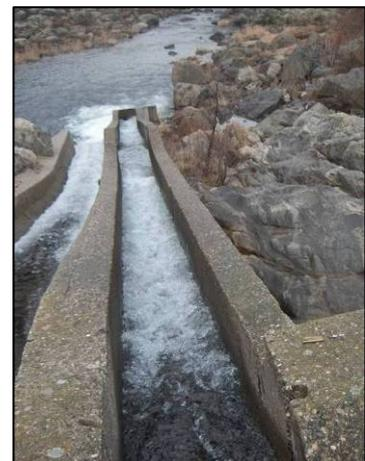
Sur les grands barrages, des passes spécifiques à anguilles peuvent également être mises en place. Elles permettent des pentes comprises entre 15 et 45 %)
