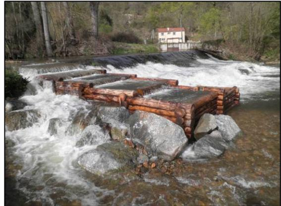
Les travaux de finition consistent à poser du bois sur la crête du seuil pour limiter le débit entrant puis de caler le débit minimum biologique avec l'entrée du bief. Le syndicat peut également réaliser des travaux de restauration du seuil si besoin.
