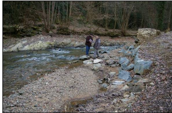
Suppression de l'obstacle (2,3 m de hauteur) sans reprise des berges et abattage de quelques arbres pour un coût de 17 000 € HT en 2010. On observe un déstockage de sédiments sur 80 m à l'amont et un dépôt sur la même distance à l'aval.
