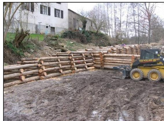
Pour le montage des bassins, différents outils sont nécessaires : un compas trusquin à 2 niveaux, une gouge large, une biseau, un écorçoir et/ou une plane, une tronçonneuse et un moyen de manutention (à droite) tel qu'un palan ou autre engin de chantier (grue).
