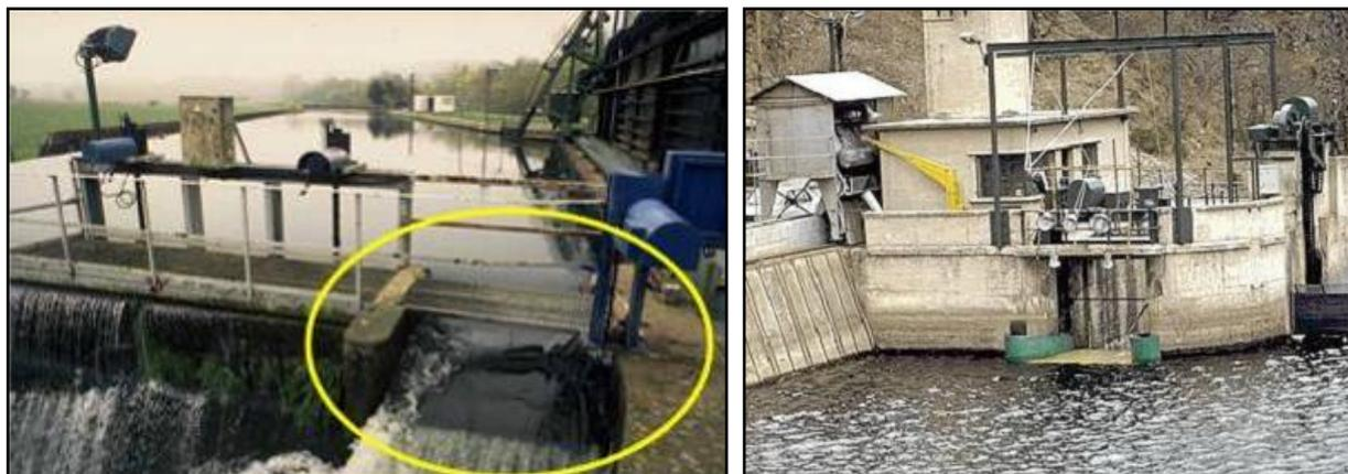
Là encore, différentes techniques peuvent être utilisées pour assurer la dévalaison. Le dimensionnement et le positionnement de l'ouvrage sont fondamentaux pour créer un débit d'appel suffisant. Les formes doivent être de préférence arrondies afin d'assurer la progressivité des débits et donc l'attractivité de l'ouvrage.
