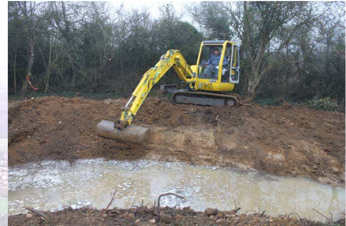
...creusement d'un fossé...
