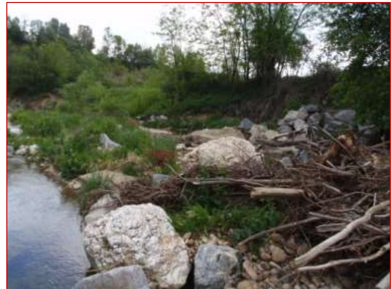
Vu d'un enrochement à enlever
