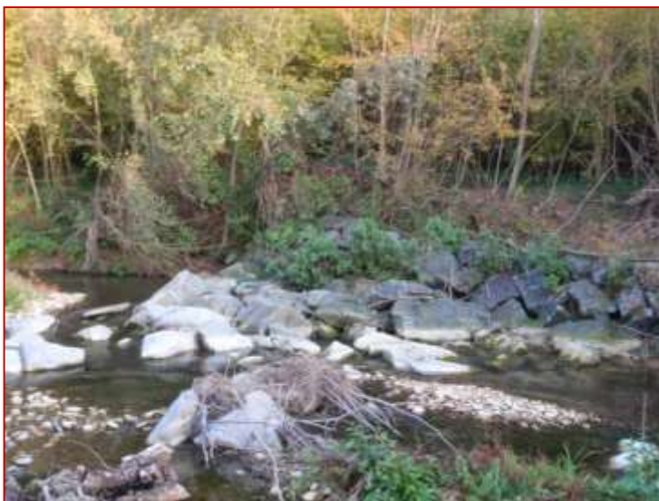
Vu des enrochements avant les travaux
