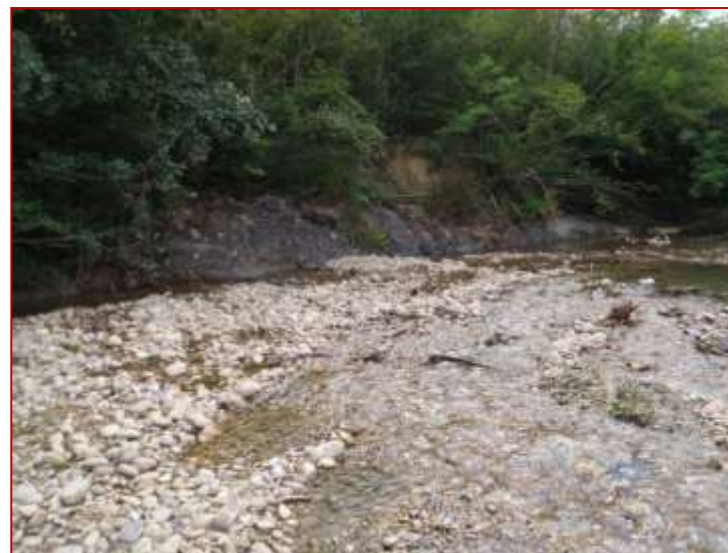
Vu du lit et des berges de la Limone après travaux
