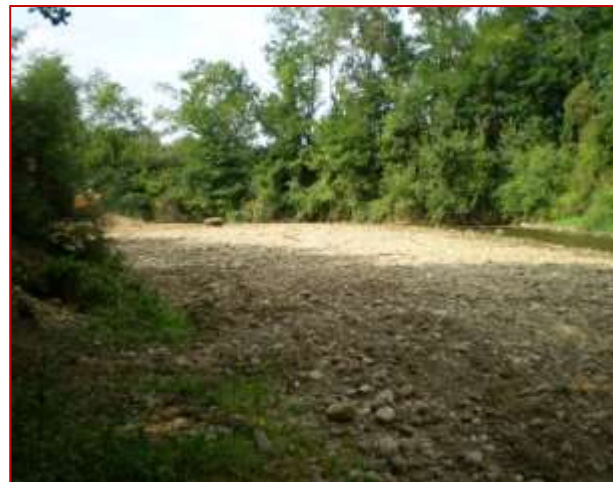
Vu de l'atterrissement après travaux
