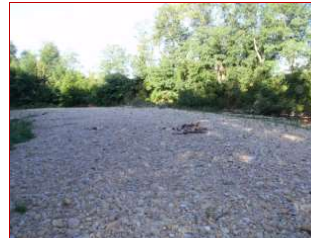
Vu de l'atterrissement 1 ans après travaux et après une crue morphogène
