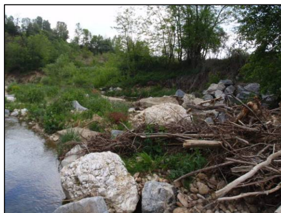
Vue d'un enrochement à enlever
