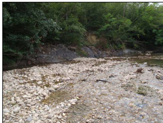
Vue du lit et des berges de la Limone après travaux
