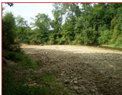
Vue de l'atterrissement après travaux
