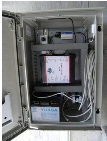
La station est alimentée par une batterie 12V-24Ah. Pour économiser de la main d'œuvre et de l'énergie, une seule acquisition de hauteur est réalisée par heure (calcul de la moyenne des hauteurs sur 15 secondes). Cela permet d'avoir une autonomie de trois mois.
