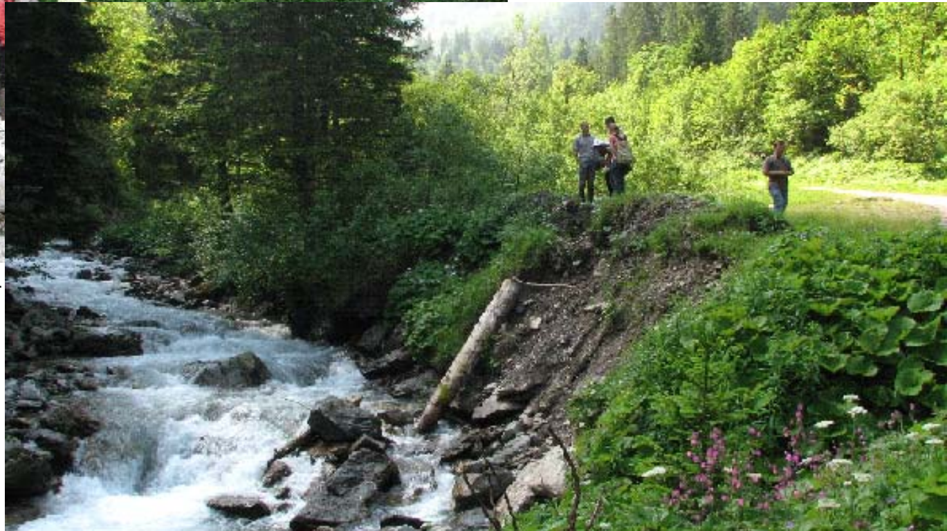
Chantier ONF - avant travaux – Zone 2 – Source : A. Matringe (ONF)
