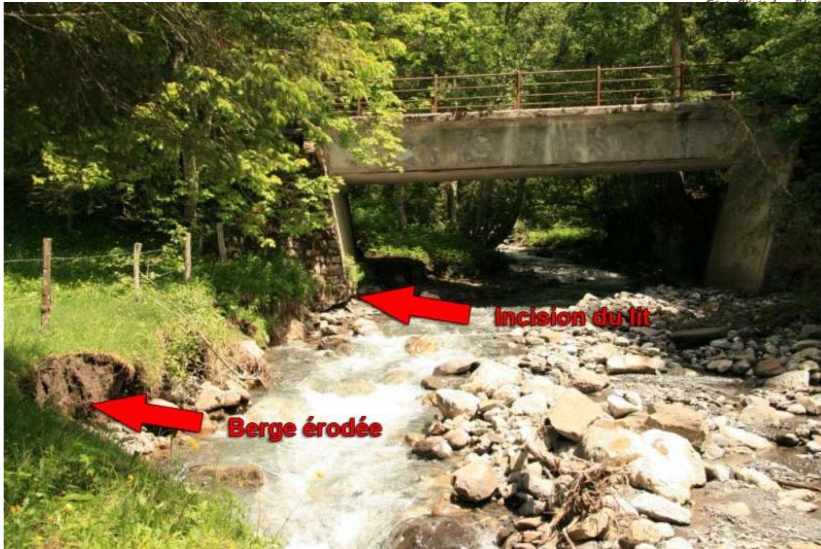
Chantier Avançon d'Azeindaz – Source : PA Frossard / L. Bonin (HEPIA)
