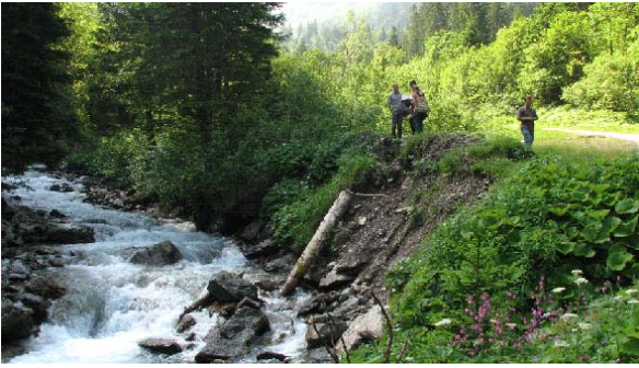
Chantier ONF - avant travaux - Zone 2 - Source : A. Matringe (ONF)
