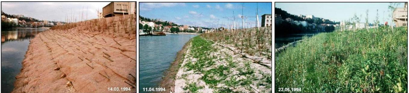
Exemple d'ouvrage réalisé à l'aide de couches de branches à rejets. De la fin des travaux (à gauche) à la reprise végétative des différentes espèces ligneuses (à droite) ; Source : *BIOTEC*.
