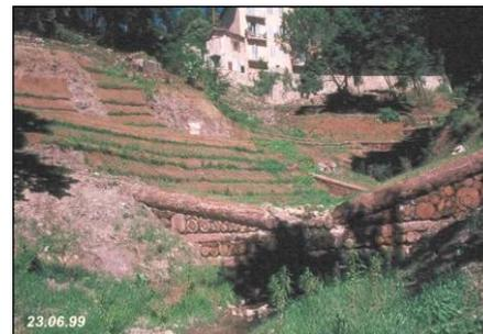
Exemples d'ouvrages réalisés à l'aide de techniques mixtes : protection de berge avec base en enrochement (à gauche), épi végétal (au centre) et barrage bois (à droite) ; Source : *BIOTEC*.
