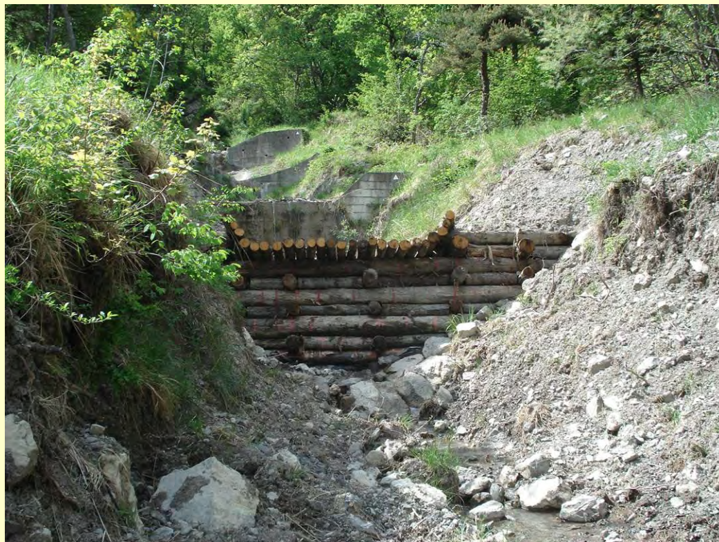
FD St EYNARD (38) / Ecorchiers / Parement châtaignier avec bouches trous 2012
