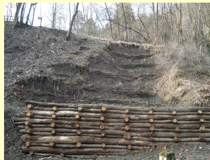
Cne La Terrasse (38) Parement en châtaignier avec bouches trous bois 2012 31
