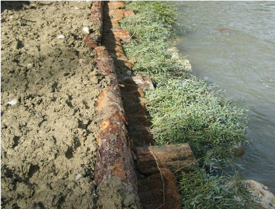
Remplissage au fur et à mesure du montage
