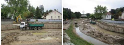
Remblaiement et compactage de la digue derrière le mur de soutènement en gabions (septembre 2012)
