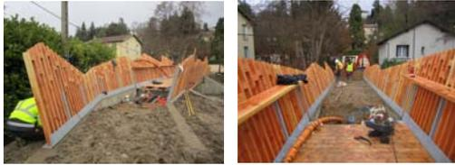
Pose du tablier de la passerelle (incluant les réseaux) et des rampes (décembre 2012)
