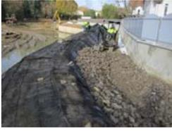
Protection par géogridde et compactage de la digue derrière le mur en gabions (novembre 2012)
