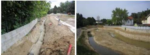
Pose d'un drain de collecte des eaux pluviales et des eaux de surverse derrière la digue
