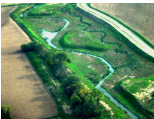
Le Vistre restauré à Bouillargues
