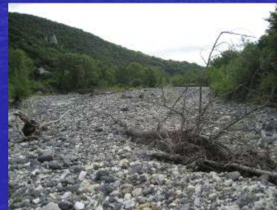
Situation MR3 avant – après travaux : **modification de la blocométrie max observée** : avant travaux (transport de R en 2003) après travaux (transport de Bpt- Bmt en 2009) permet
