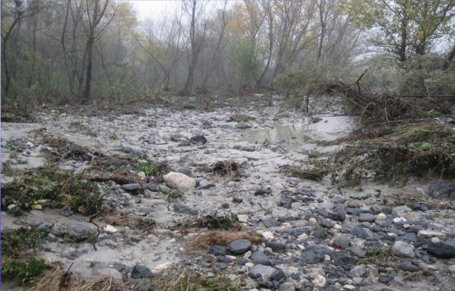
Situation MR3 : **post crue en 2007** : bon fonctionnement de la terrasse, divergence et diversification des flux d'écoulement au droit du secteur, peigne à embâcles, zone d'expansion qui permet une reconnection hydraulique sur plus de 1 hectare + **reconnection hydromorphologique : création d'un nouveau chenal.**
