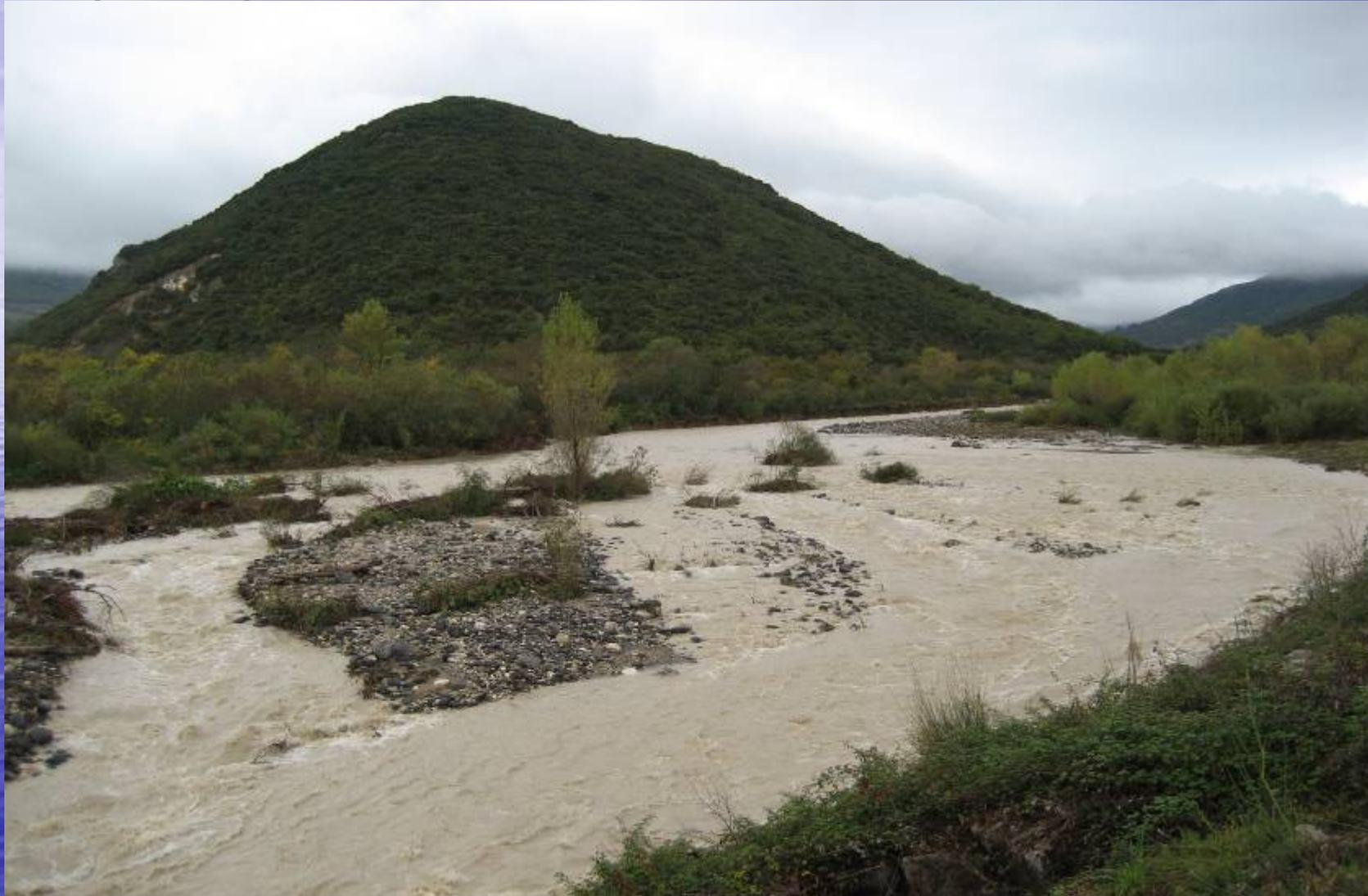
Situation MR3: après travaux en 2008 : Modification progressive des conditions hydromorphologiques au sein de la bande active : **zone réceptrice d'embâcles : réduction des distances des corps flottants en crue, réduction des érosions latérales, réduction des risques de routes emportées : 20 ml en extrados en 2003 = 2 à 5 ml sur la même zone en 2008!!...**
