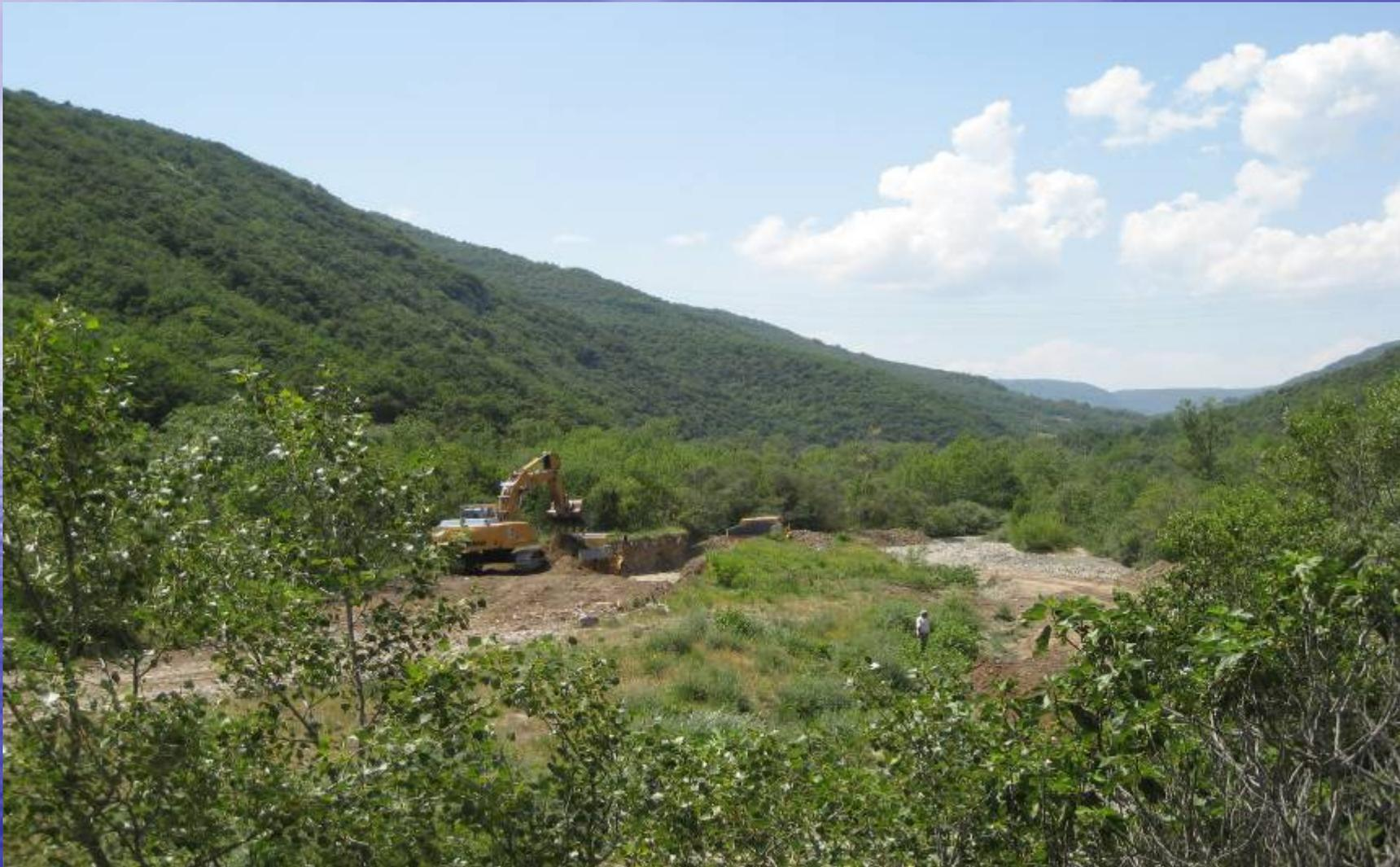
Situation M4 : après travaux **en 2006** : fonctionnement hydraulique de la terrasse restaurée, bande de végétation au sein des deux bras permet de recréer une diversité hydraulique puis morphologique en crue.
