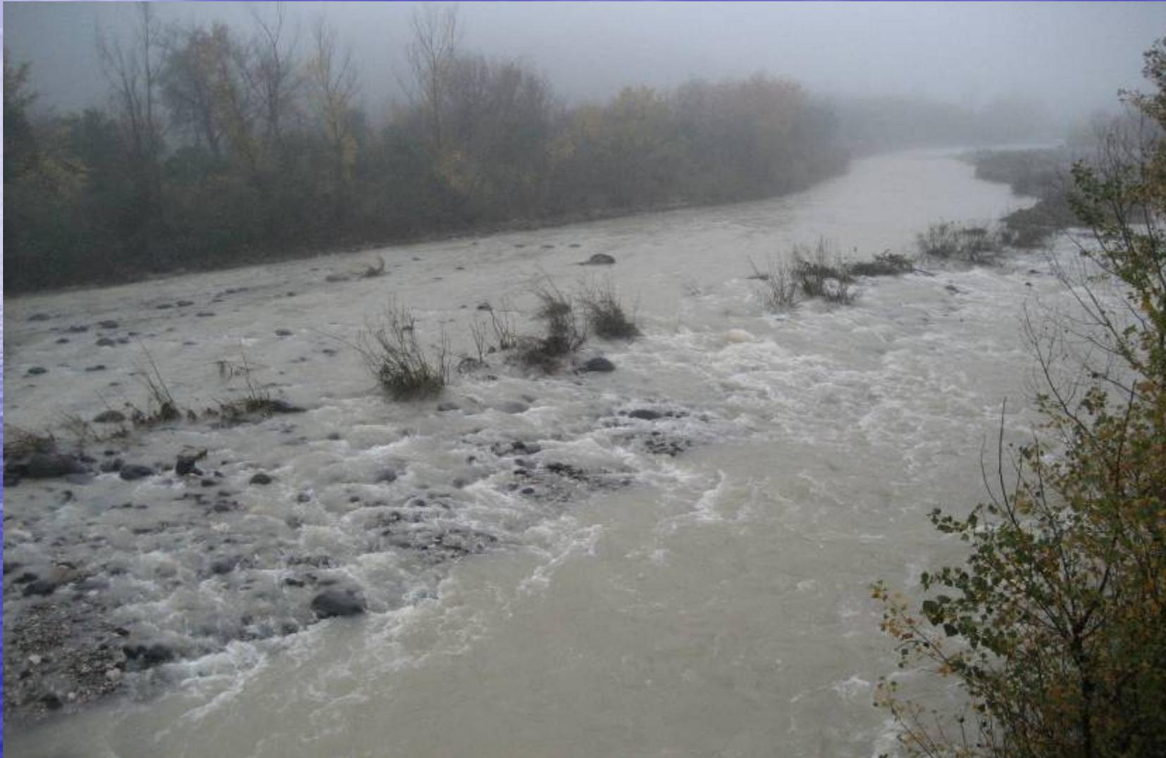
Situation M4: après travaux **en 2008** : Modification progressive des conditions hydromorphologiques au sein de la bande active : création de plusieurs chenaux d'écoulement, **restauration de la respiration verticale**, **adaptation au caractère méditerranéen (crues morphogènes, étiages sévères)**.
