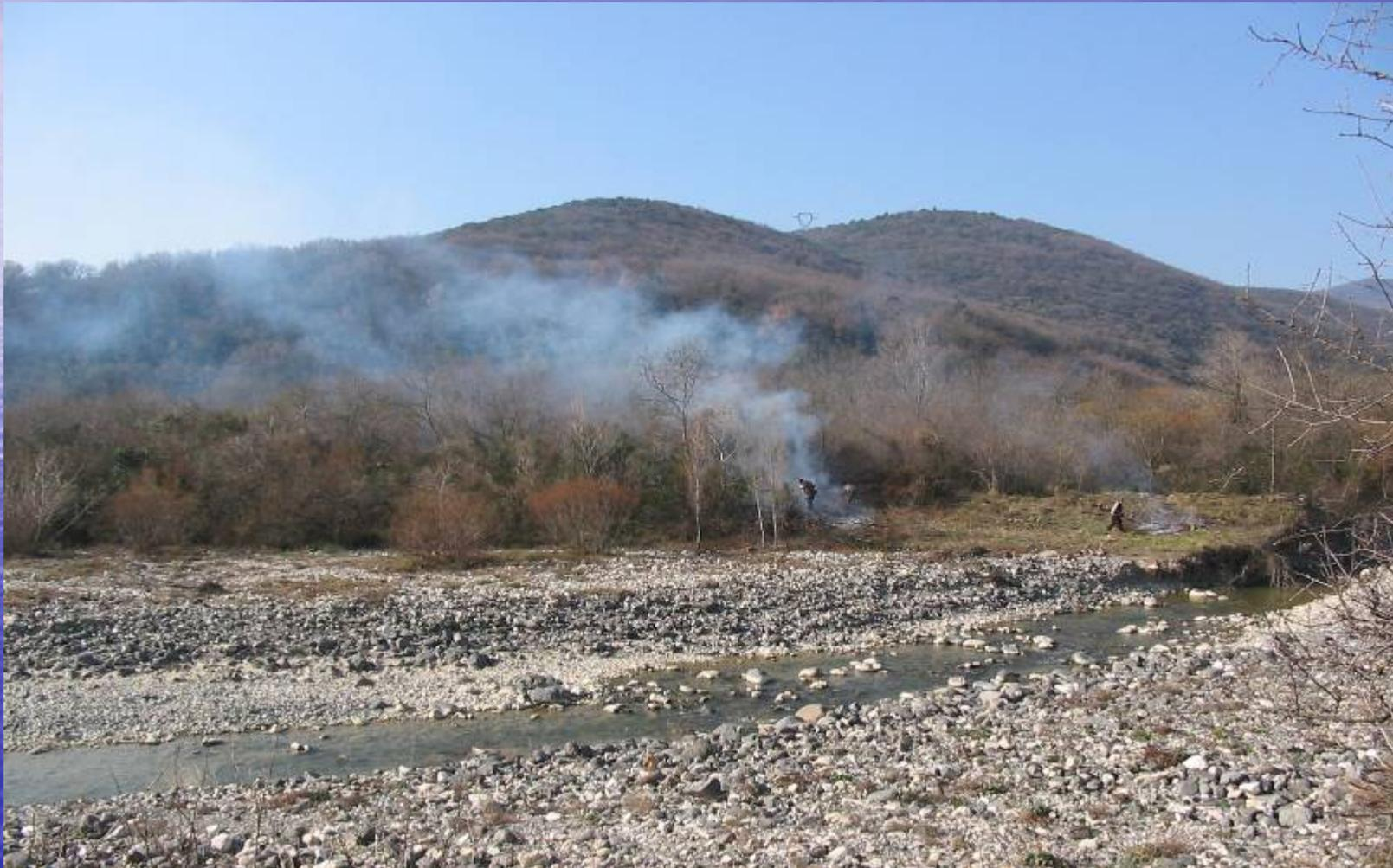
Situation MR3: après travaux **en 2006** : traitement systématique de la végétation sur le bourrelet avec pour objectif la gestion des alluvions. **Maintien de la végétation existante (création d'un îlot végétalisé)** en bordure du bourrelet de recalibrage (coté cours d'eau).
