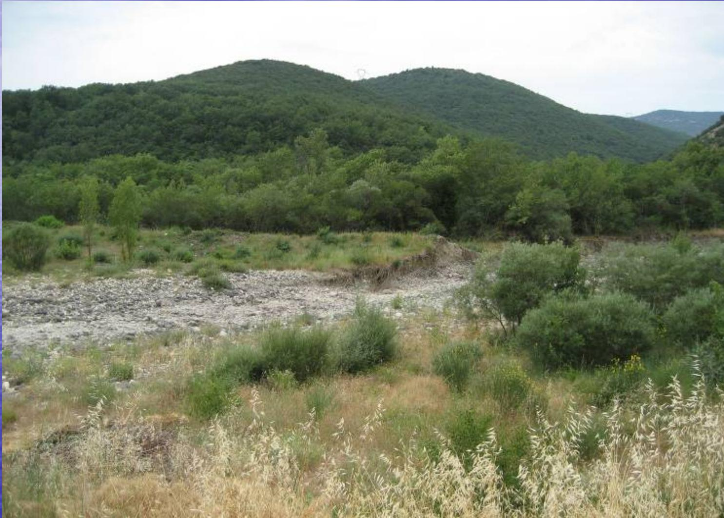
Situation MR3: après travaux **en 2006** : Élimination du bourrelet de recalibrage afin d'élargir la bande active du lit. Maintien de la végétation existante (maintien d'un îlot végétalisé) au centre du lit.
