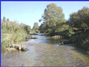
Mise en place d'épis déflecteurs
