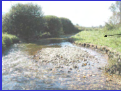
Secteur aval péage A404 Mise en place de banquettes et blocs de diversification
