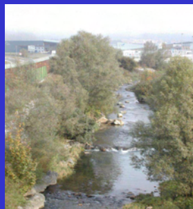
Vue après travaux du secteur d'intervention
