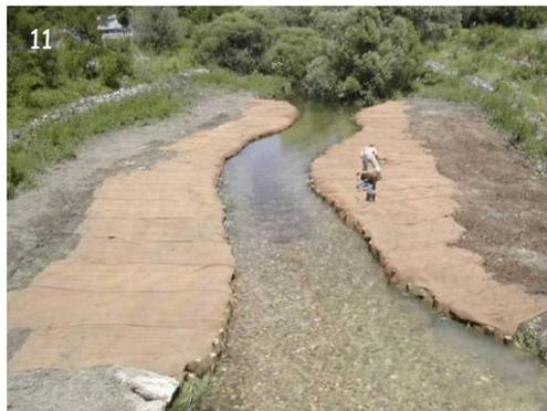
Les banquettes sont constituées de matériaux de remblai issus du décaissement de la berge et mis en place sur un géotextile coco. L'ensemble est stabilisé en bordure de lit par des pieux battus d'acacias. Le bombement ainsi créé est nappé de terre végétale avant d'être recouvert par le combiné coco en une sorte de « chaussette », évitant ainsi l'entraînement des fines. Le tout est ensuite planté d'hélophytes, à raison de 5 unités/m<sup>2</sup>.
