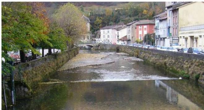
Photo 1 : banquettes alternées à l'étiage. Le lit mineur est resserré, la lame d'eau et les vitesses d'écoulement sont augmentées
