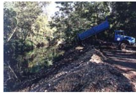
Dépôt des graviers en vrac sur le talus de berge
