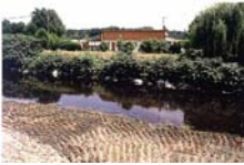
Scarification de la surface du banc arasé
