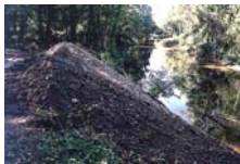
Dépôt des graviers en vrac sur le talus de berge
