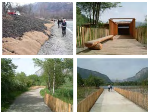
L'aménagement du lac des Ilettes : une opération de valorisation dans le cadre du contrat de rivière de la vallée de l'Arve
