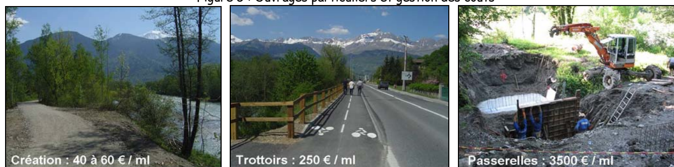
Figure 5 : Ouvrages particuliers et gestion des coûts
