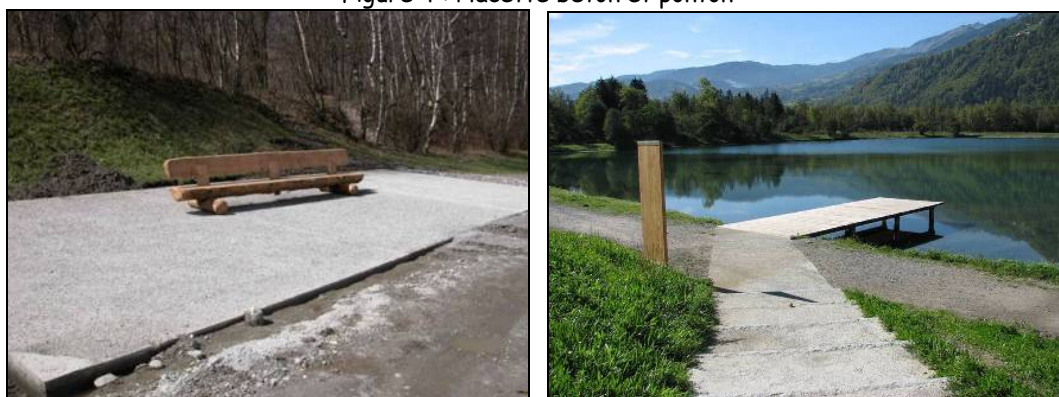
Figure 4 : Placette béton et ponton
