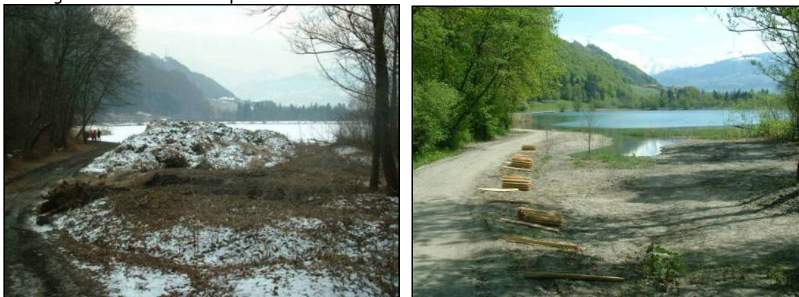
Figure 1 : Site avant et après les travaux de terrassement et le creusement du bras secondaire
