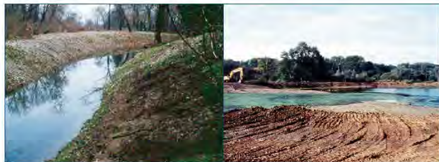
Figure 31 : Terrassements de berges d'annexes hydrauliques en pente élevée à gauche, offrant peu de place à la diversité biologique et variations de profils beaucoup plus doux à droite, devant permettre la reconstitution de séries végétales adaptées. ≡
